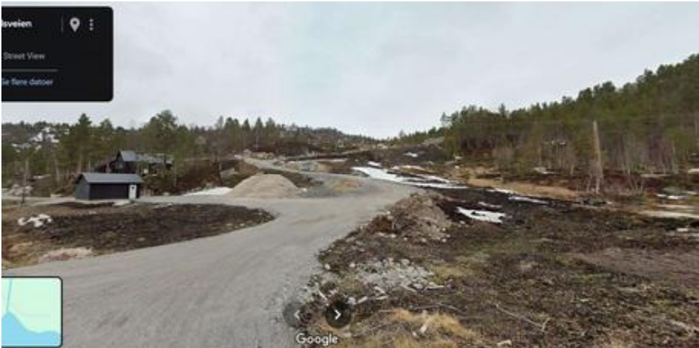
Figur 2 Utbygging av vei sett fra fylkesveien. (Google Streetview)
