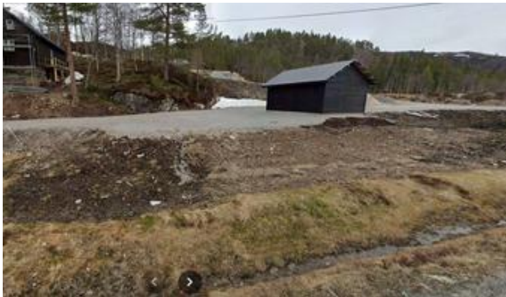
Figur 7: Redskapshus som er ført opp nede ved fylkesveien
